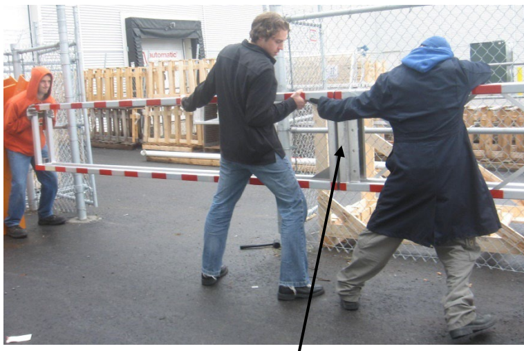
Skjut in hinderets änddel i basdelen
