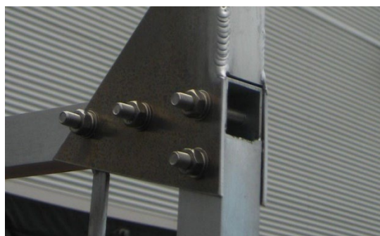
Muttrarna måste vara på den säkra sidan
