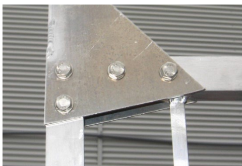
Bultarnas huvuden måste vara på icke säkra sidan
